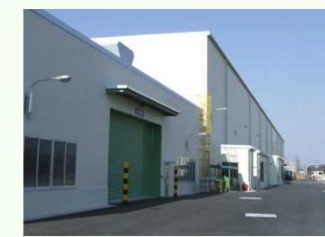
圧延工場建屋増築
