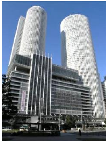
柱や梁として利用
