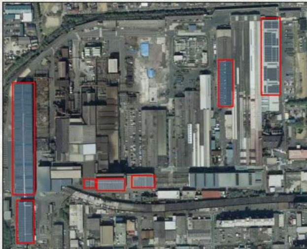
中部鋼鉄太陽光発電所 設置状況
