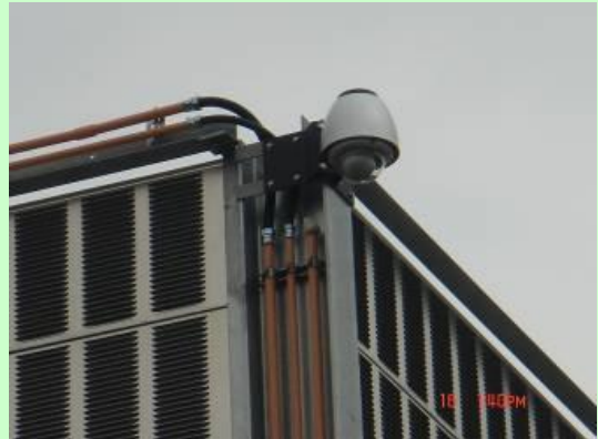
カメラ設置状況
