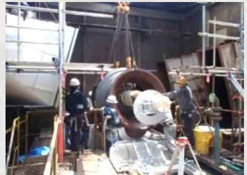
電気炉集塵機ブローア更新中
