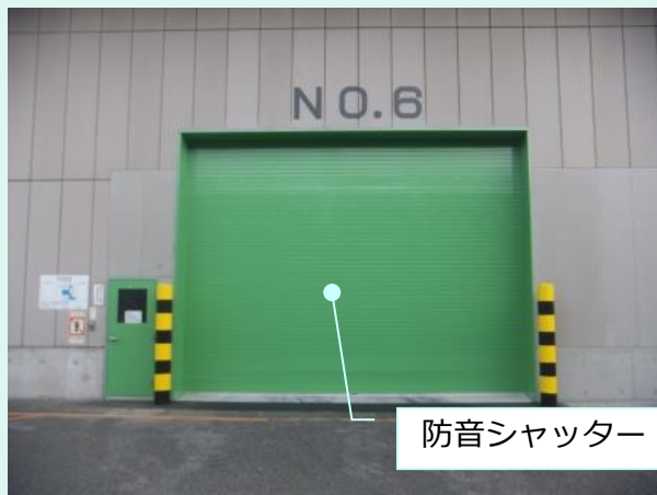
圧延工場北側のシャッター防音化
