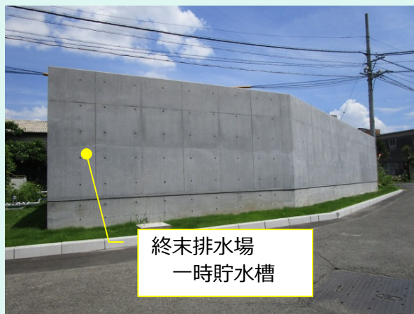
新設した一時貯水槽（側面から撮影）
