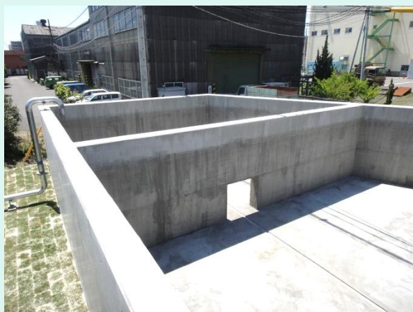
新設した一時貯水槽（上部から撮影）
