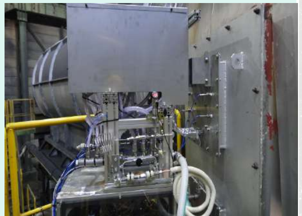
熱電発電ユニット設置状況
