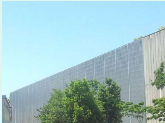
西側防音壁（延長部）設置状況
