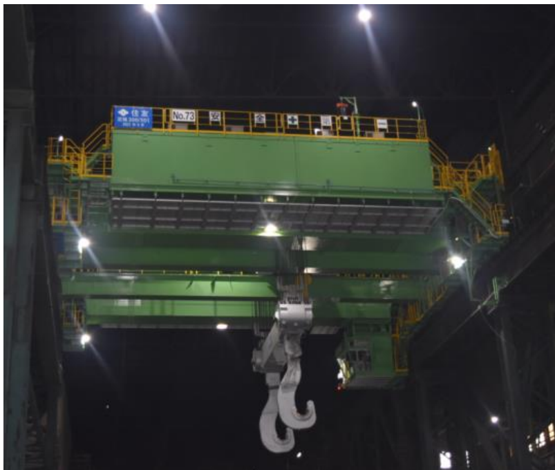
写真 完成したクレーン全景
