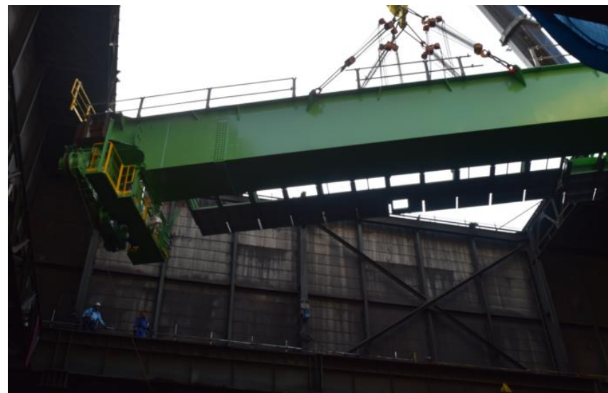
写真 工事中的様子
