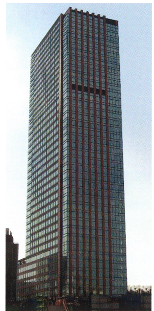
物件名：住友不動産(株) 三田ツインビル西館 43階建て超高層ビル 延べ床面積：9万9千m 2 竣工：平成18年
