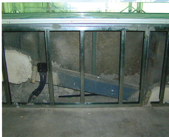
鋼製ブレース一例
